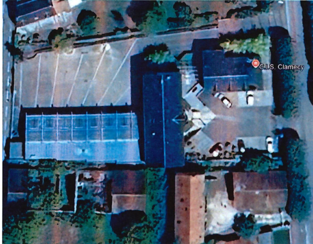
Photo vue d'ensemble du site :
